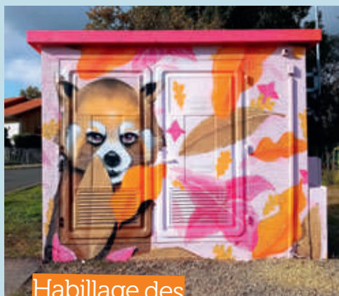
Qualité de vie Aménagement autour du four du Corail
