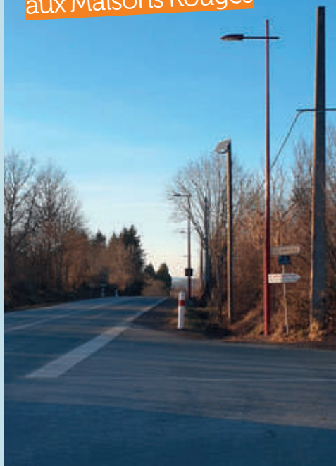
Pose de mats d'éclairages (4 aux Maisons Rouges et 11 aux Fontêtes) et d'un radar de sécurité fixe aux Maisons Rouges
