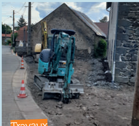
Travaux au Bouchet
