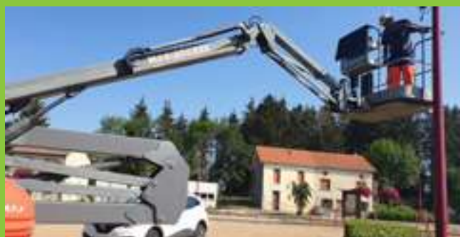
Pose d'éclairage au terrain de pétanque
