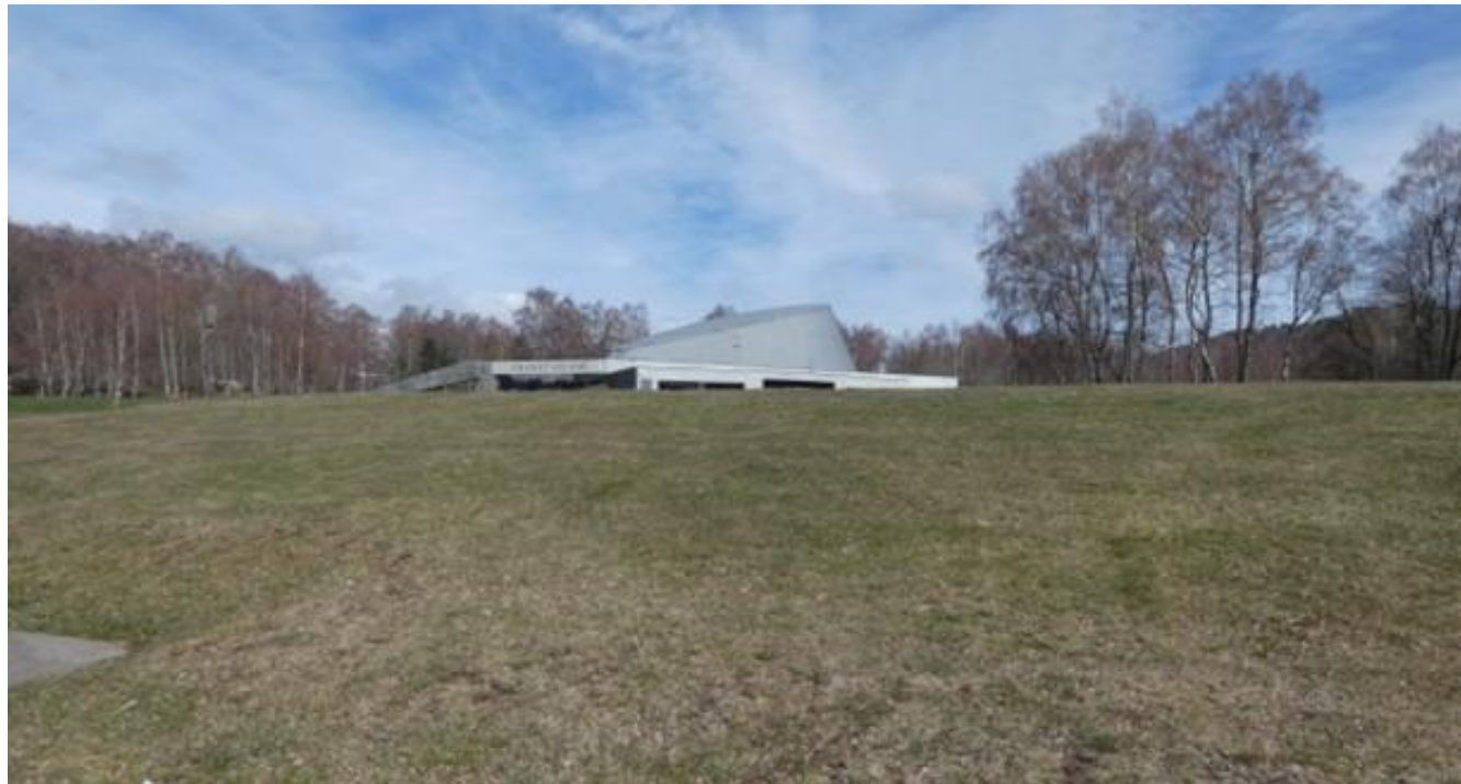
Figure 7 : Vue depuis l’entrée principale du site de Vulcania – source : SOLER IDE, avril 2026
