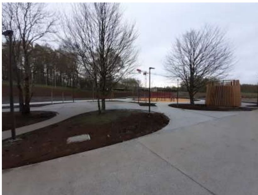
Figure 2 : Photographies de la place des volcans une fois les travaux terminés (Source : IDE Environnement, mai 2021) .
