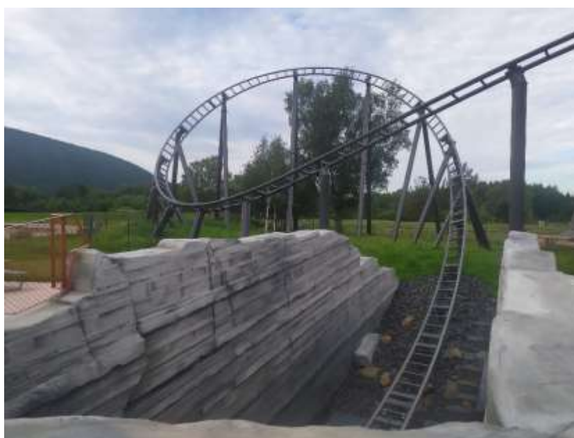
Figure 2 : Photographies de l'attraction Ride (Namazu) une fois les travaux terminés (Source : IDE Environnement, juillet 2021) .
