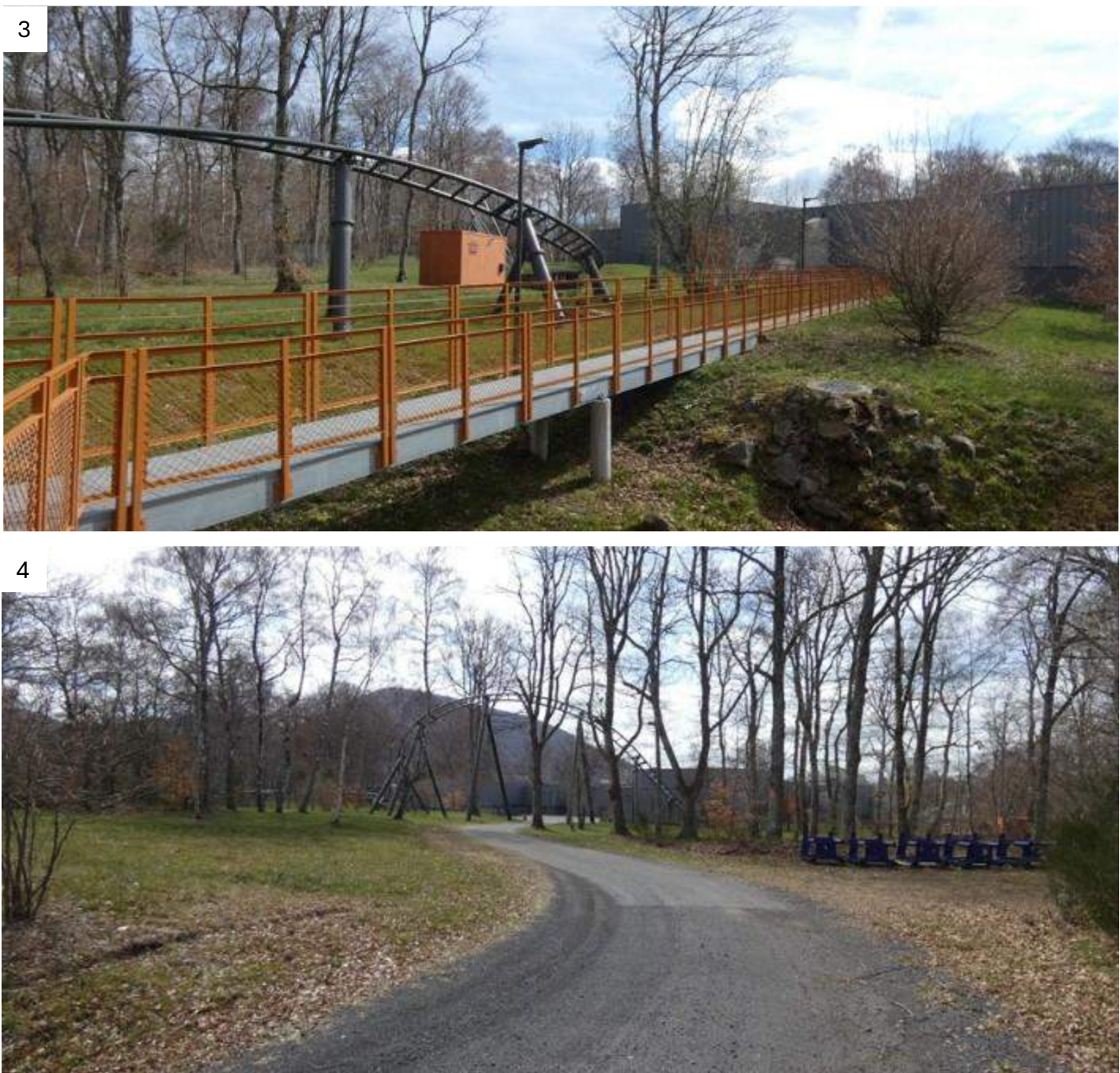
Figure 17 : Photographies du Namazu en phase exploitation - Source : SOLER IDE, avril 2026
